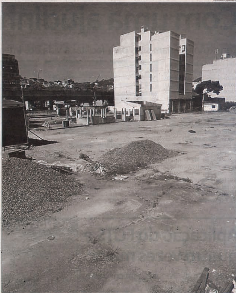
CANTEIRO DE OBRAS de empreendimento da MRV, no Rio Comprido: estruturas padronizadas
