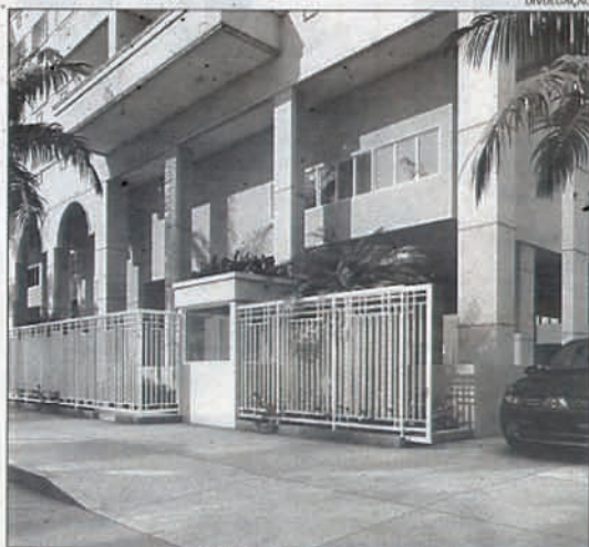
PRÉDIO DA LIVING, em Vila Valqueire: economia de 10% na obra
